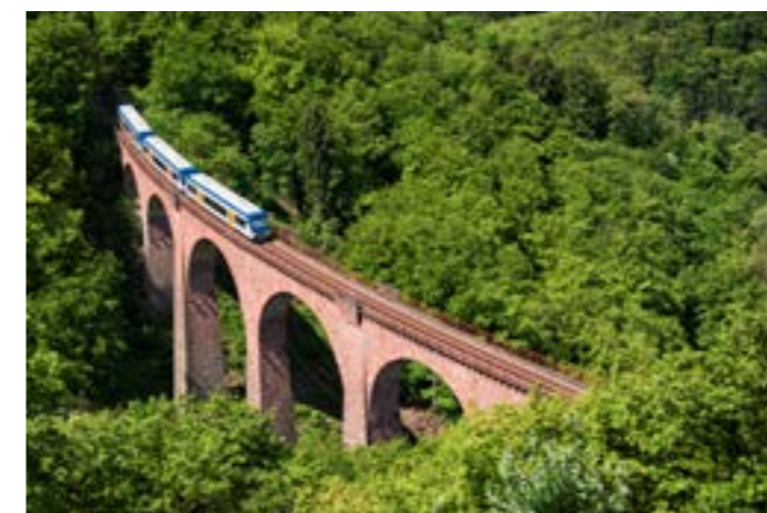
Das Hubertus-Viadukt aus dem Jahre 1907 ist das aufwändigste Bauwerk der Hunsrückbahn. Es überspannt die Hubertusschlucht, ist 58m hoch und 150m lang.
